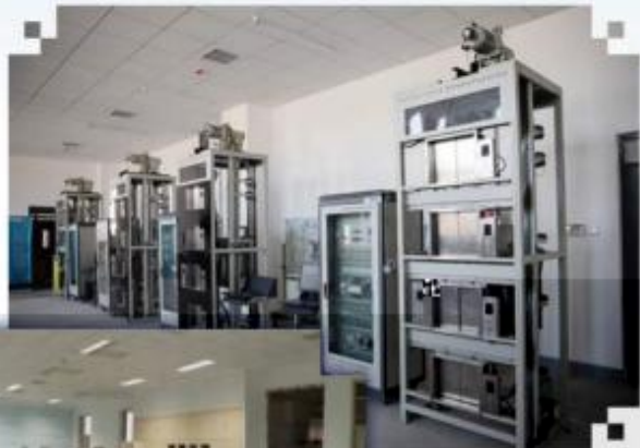
智能电梯安装调试 维护训练场所
